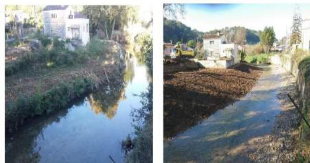
Fig. 7 / Talutage des berges en pente douce et élargissement de la section d'écoulement. © CASA
